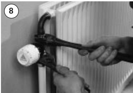
Fastgør beskyttelsesrøret i gulvet og tilslut radiatoren.
