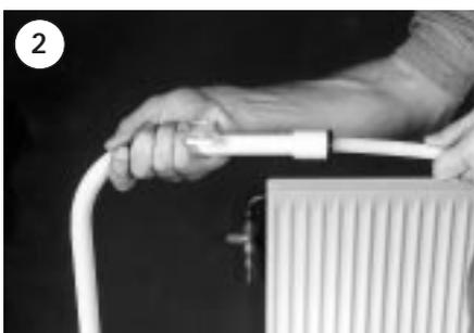
Tomrøret afkortes i en passende længde (ca. længden på beskyttelsesrøret). Pex-røret føres op gennem beskyttelsesrøret. Det kan være vanskeligere at montere 15 mm Pex-rør end 12 mm.
